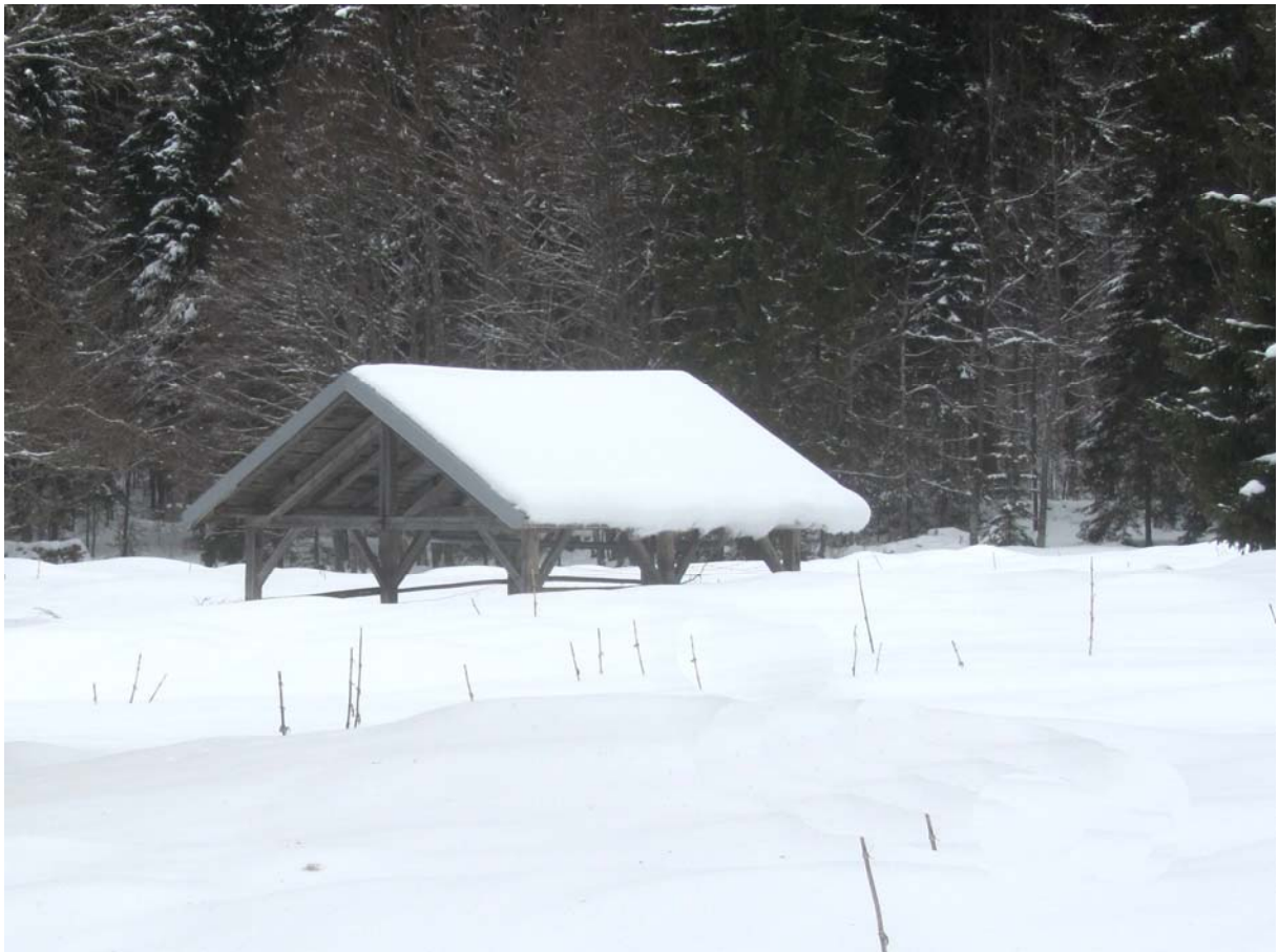
Couvert de citerne du Cul du Bois, proche de la Frasse.
